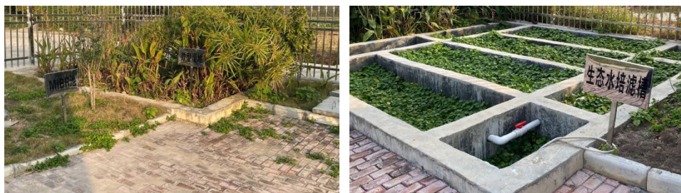
图 6-30 来宾市兴宾区蒙村镇铁象村生活污水治理项目
