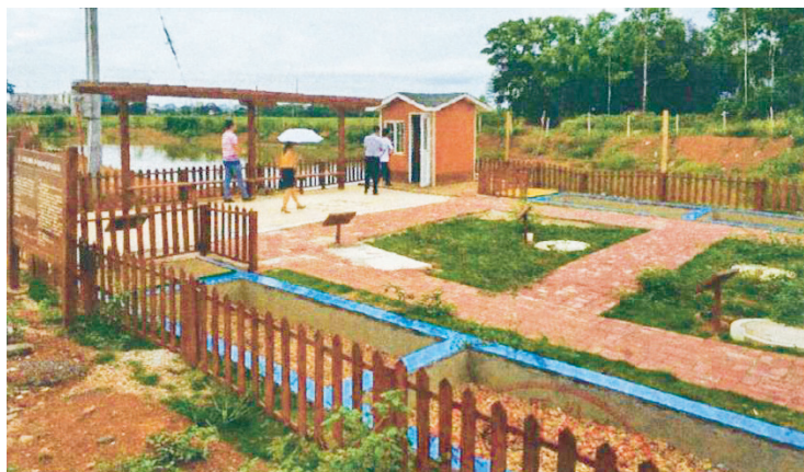
图 6-21 南宁市宾阳县黎塘镇新兴村生活污水治理项目
