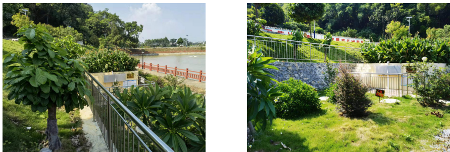
图 6-6 南宁市隆安县乔集镇培正村龙生内屯生活污水治理项目
