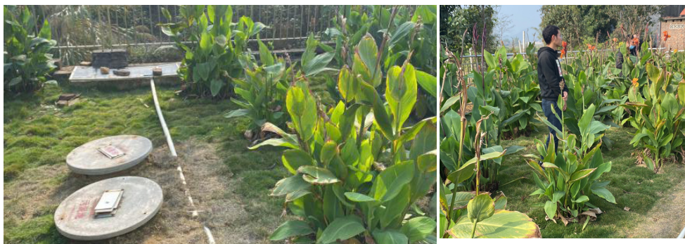
图 6-17 来宾市忻城县古尧村板凡屯生活污水集中治理项目
