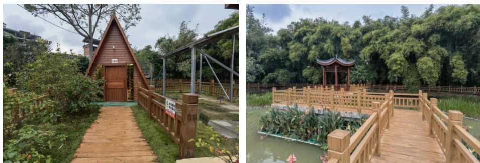
图 6-11 梧州市长洲区倒水镇富万村生活污水治理项目
