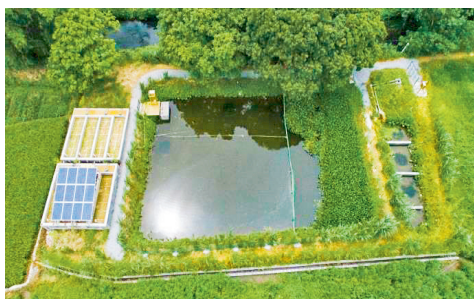
(a) 生态处理设施全貌
