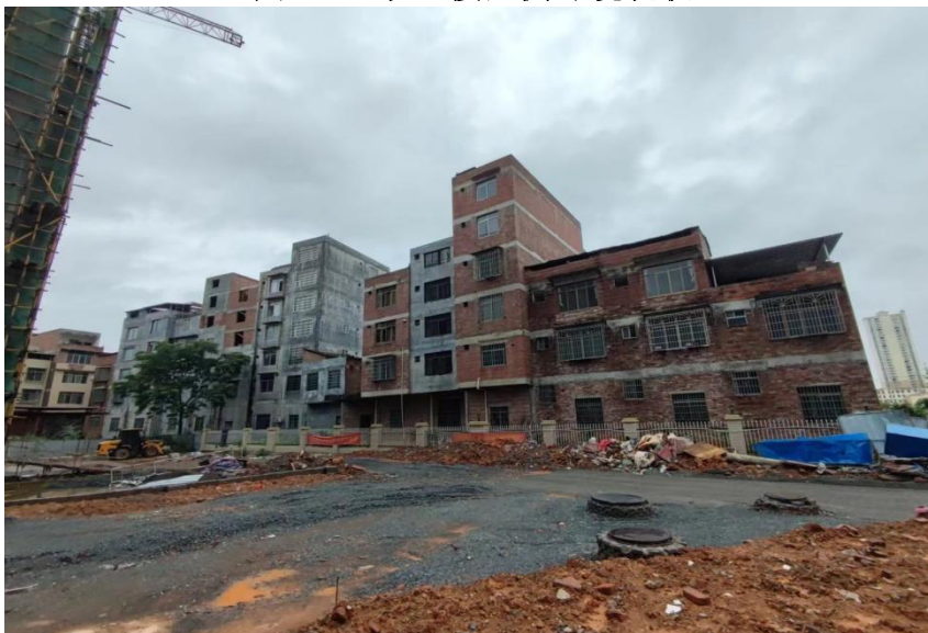
图 1-8 致远楼北侧环境现状
