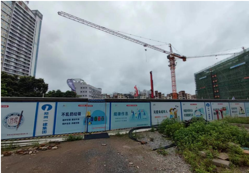
图 1-7 致远楼西侧环境现状
