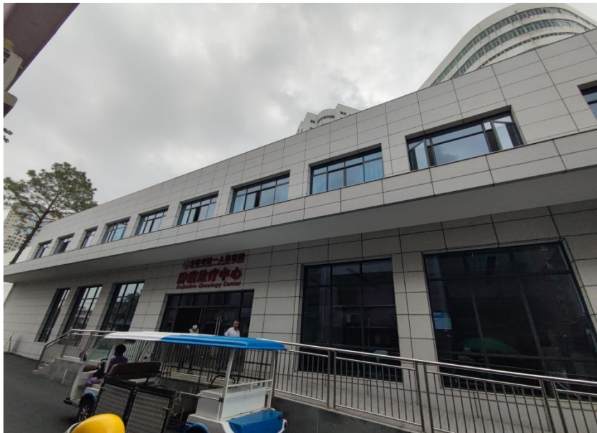
图 1-3 项目拟建场址东侧环境现状
