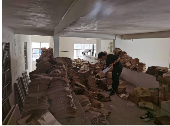
拟建机房正上方现状
