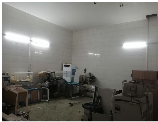
拟建机房内部现状
