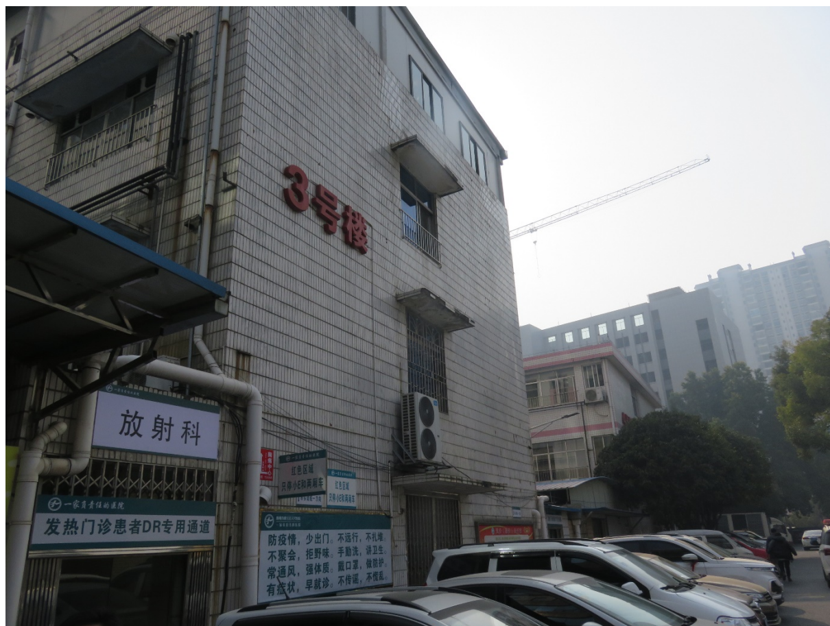
图 1-4 项目建设场址南侧 3 号楼
