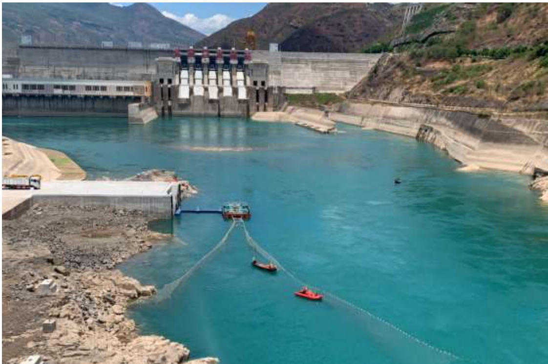
图 7.1-4 固定式集鱼平台（示意图）
