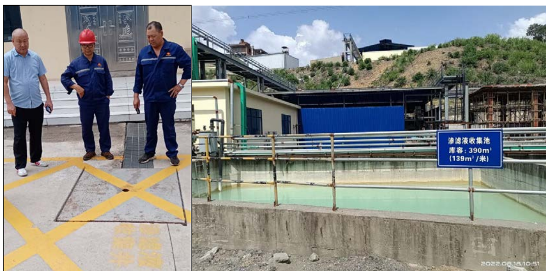
图 4.9-1 吉朗铝业渗滤液收集井和收集池
