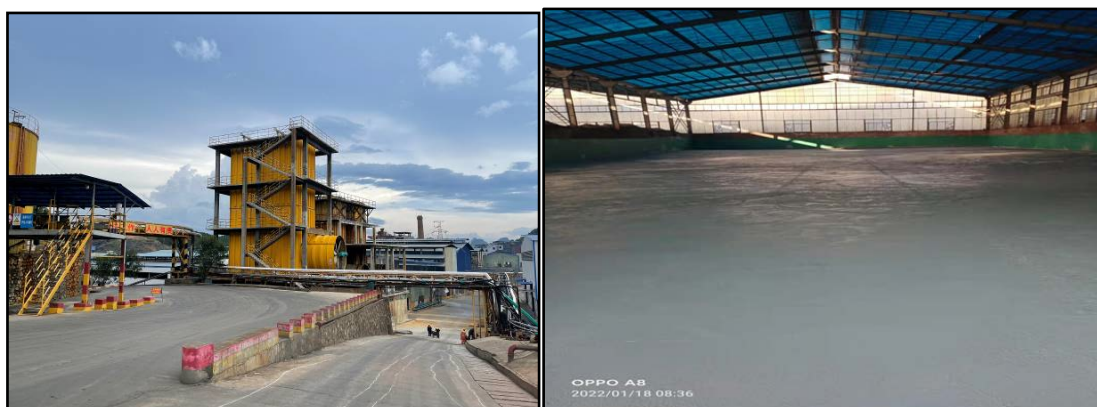
图 4.9-3 厂区地面硬化和危废原料库防渗
