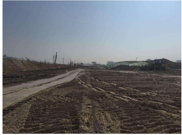
源库南侧现状
