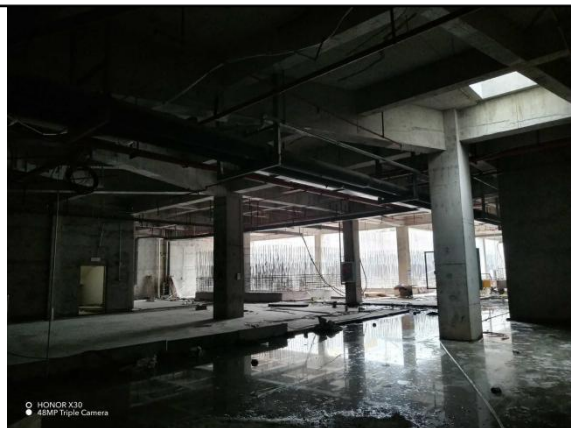
4#地下室负一层放疗科机房
