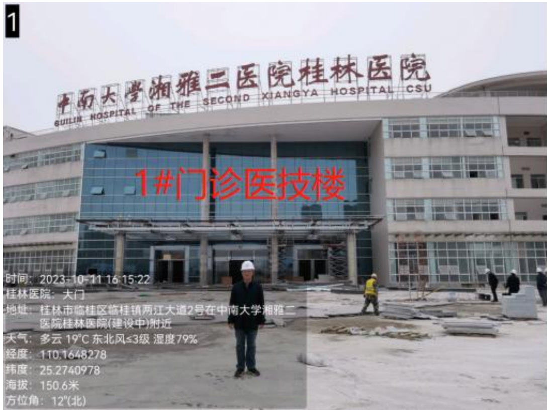
1#门诊医技楼南侧入口、工程师现场踏勘
