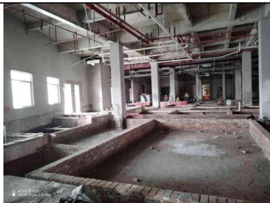
1#门诊医技楼一层核医学科场所 (1)
