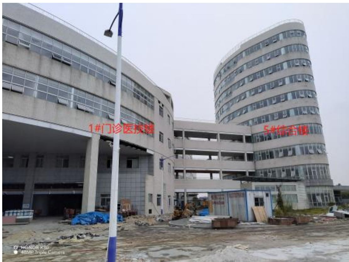
1#门诊医技楼北侧5#综合楼
