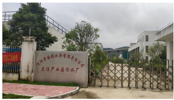
园区污水处理厂
