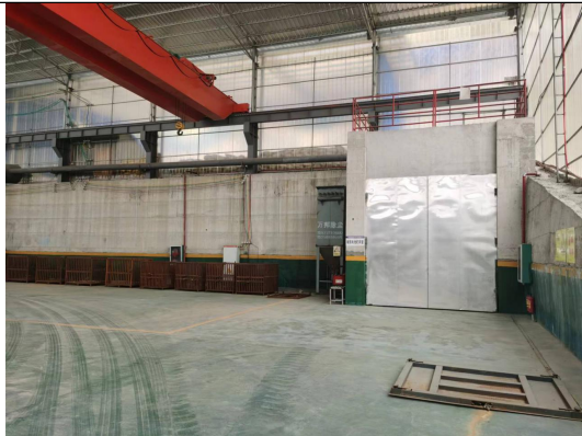
已建成破损电池间
