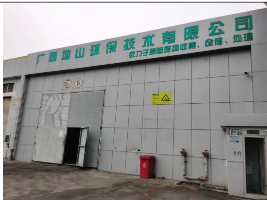
贮存设施外部
