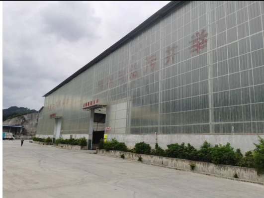
贮存设施外部
