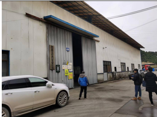
贮存设施外部
