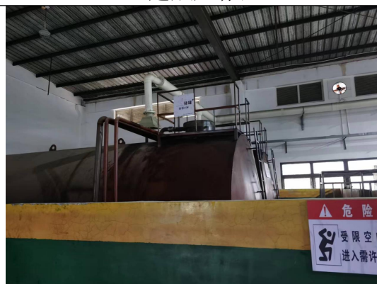
已建成储罐区
