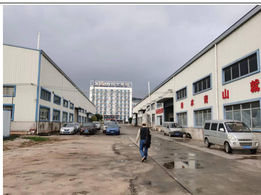
贮存设施外部
