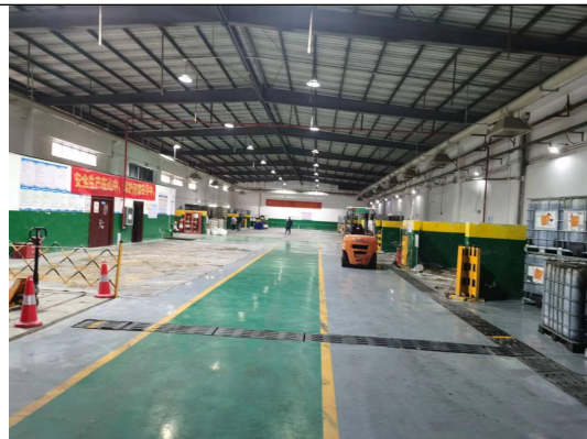
已建成贮存区
