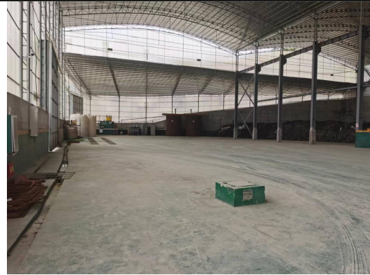
已建成贮存区
