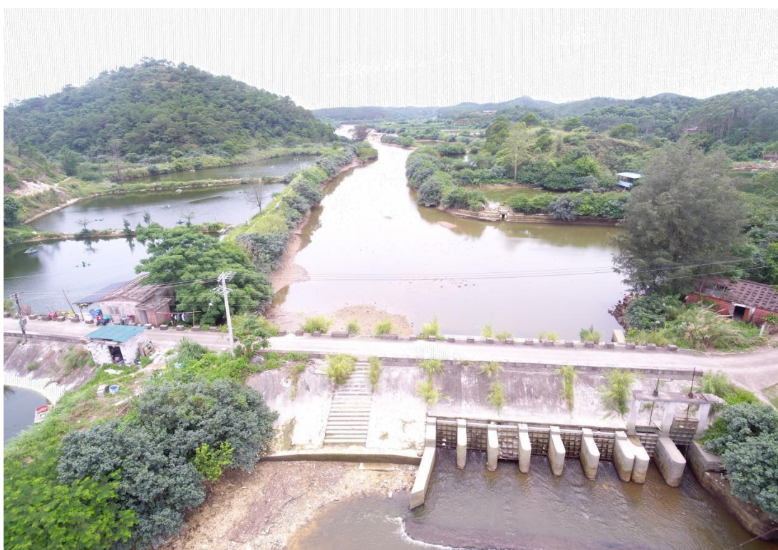
图4.8-1 白沙沟赤泥堆场工程下游挡潮闸
