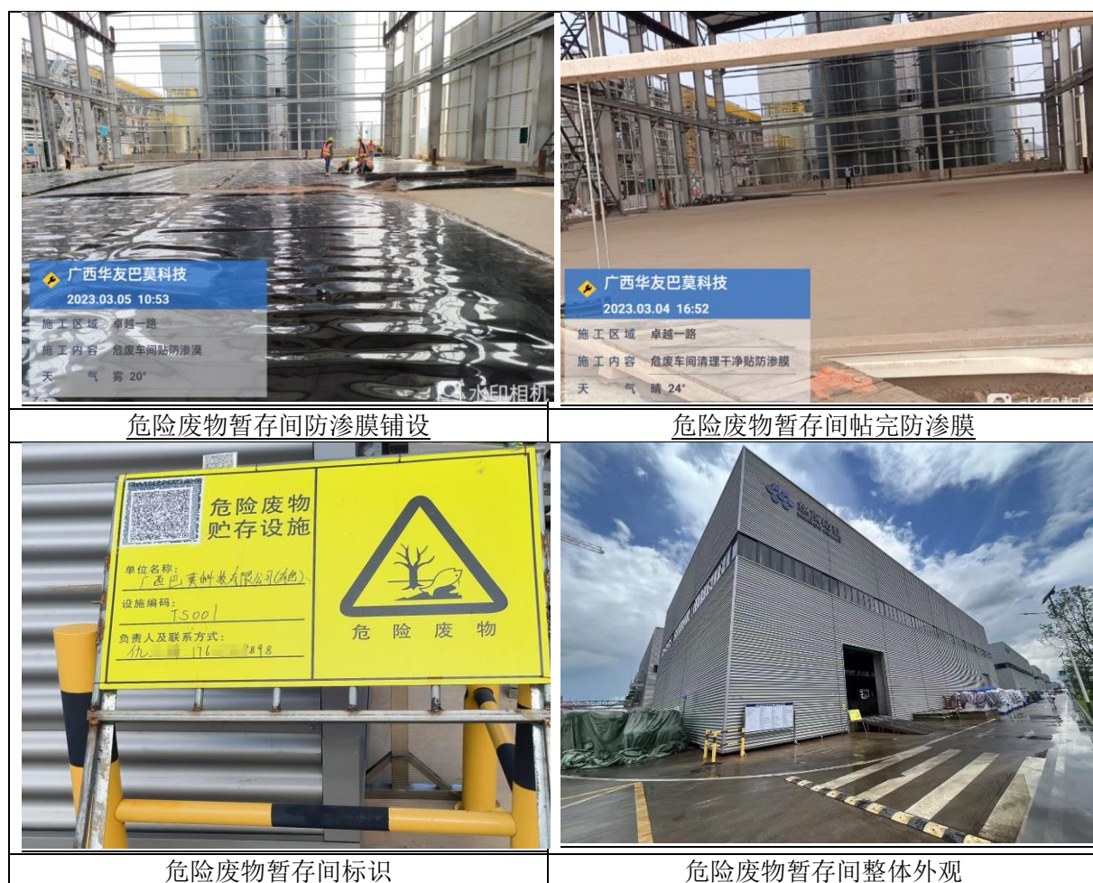
图6.2-2 巴莫项目危废暂存间建设情况
