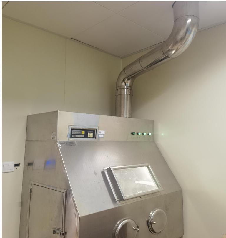
图 10-11 本项目  $^{90}\text{Y}$  分装拟用分装通风橱（原  $^{131}\text{I}$  分装通风橱）
