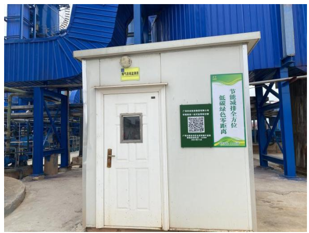
锅炉烟气在线监测房
