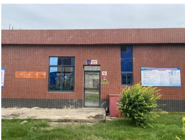
危险废物暂存间
