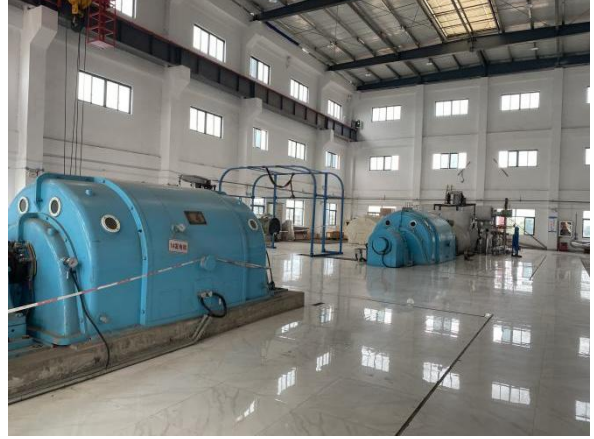
背压式汽轮发电机组
