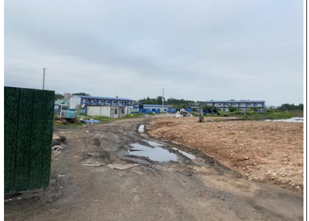
二期工程用地现状
