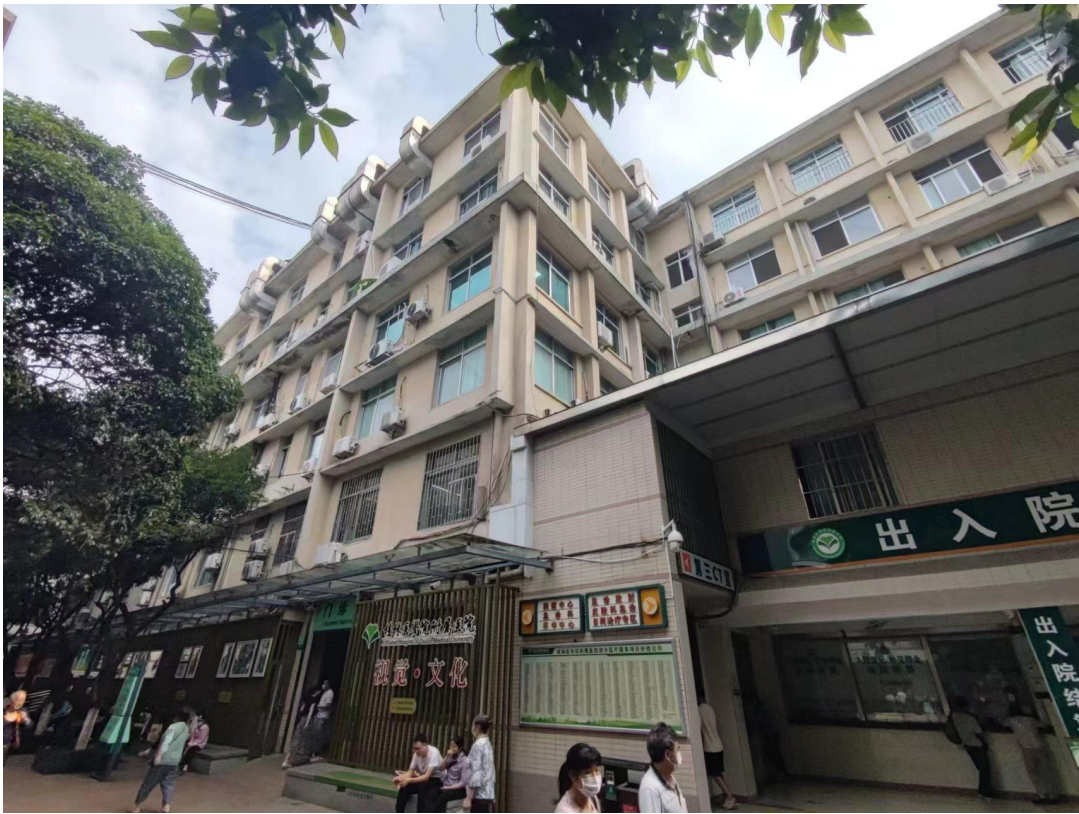
图 1-9 2号楼北侧门诊楼现状
