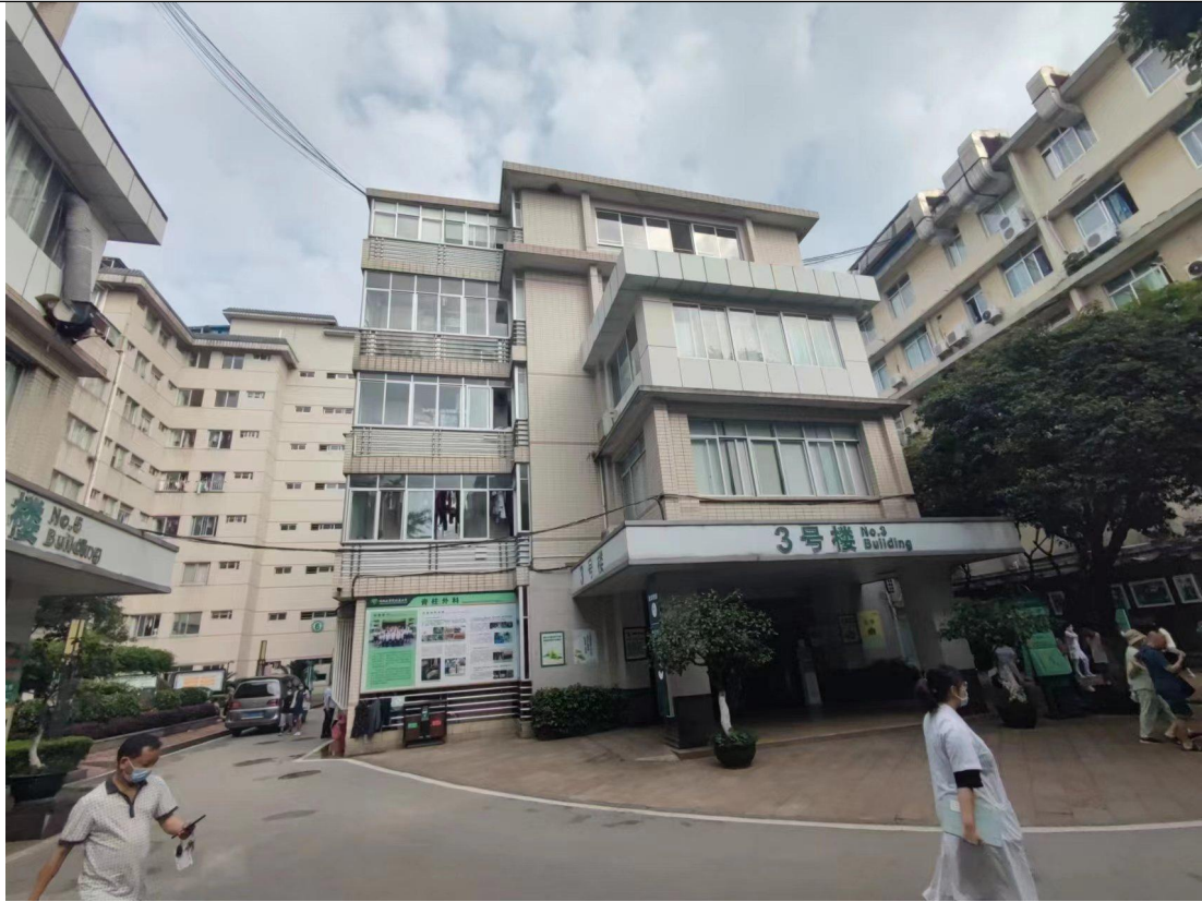
图 1-7 2号楼西侧3号楼妇儿楼现状
