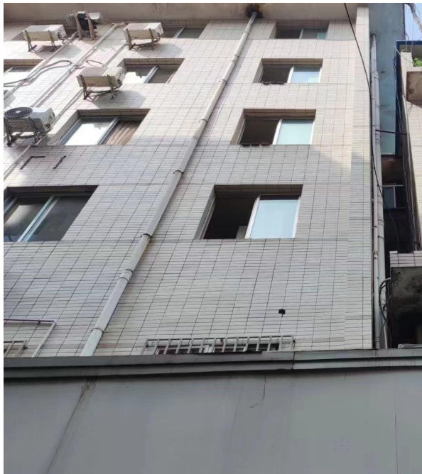
图 1-5 2 号楼东侧行政楼现状
