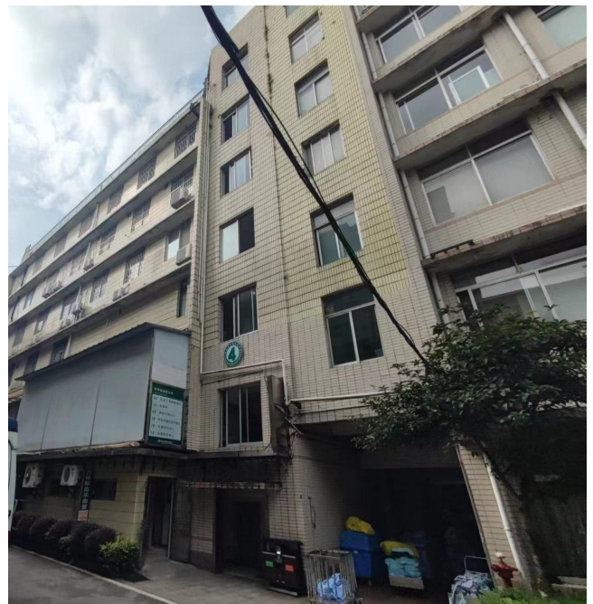
图 1-6 2 号楼南侧 4 号楼消毒供应中心楼现状
