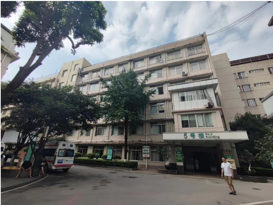
图 1-8 2号楼西南侧5号楼内科楼现状
