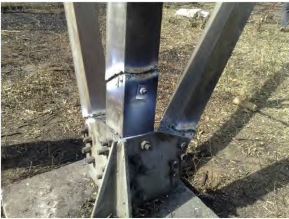
图 3-4 塔腿主材及八字铁切割工程实景图
