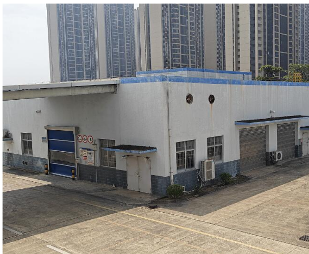
图 1-9 项目所在铁棚房西侧清洁度检验室
