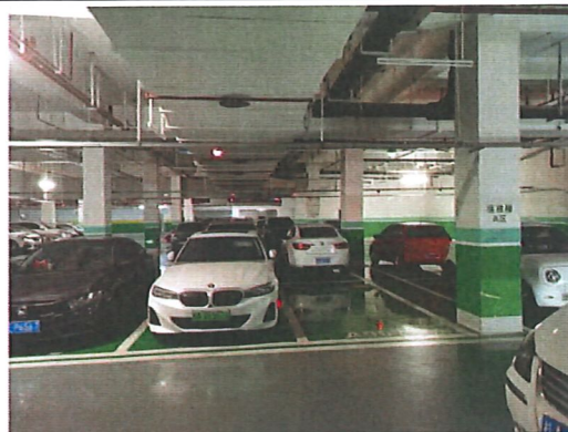
图 1-7 拟建场所楼下停车场
