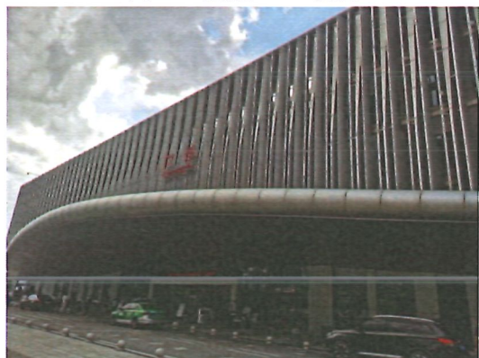
图 1-4 南侧 1 号门诊大楼
