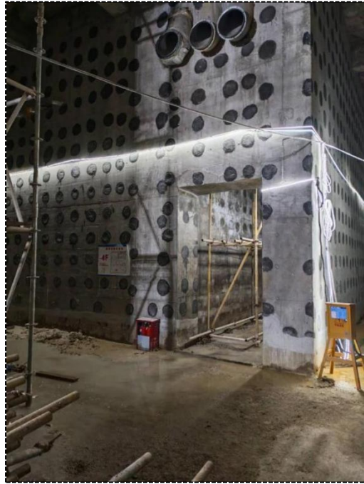
图 1-3 拟建后装机房负四楼现状
