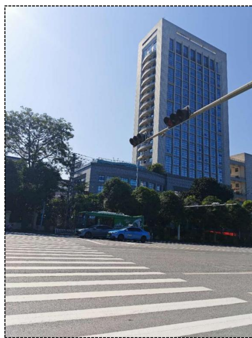
1-5 所在楼南侧院现状
