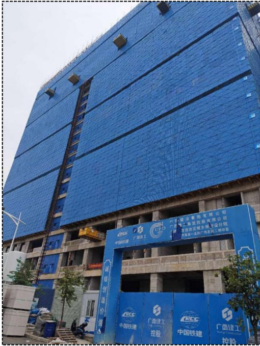
图 1-2 拟建后装机房本栋楼现状
