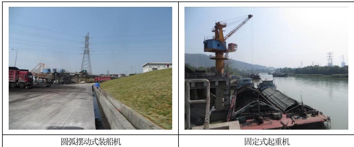
图2.3-1 码头前沿装卸设备
