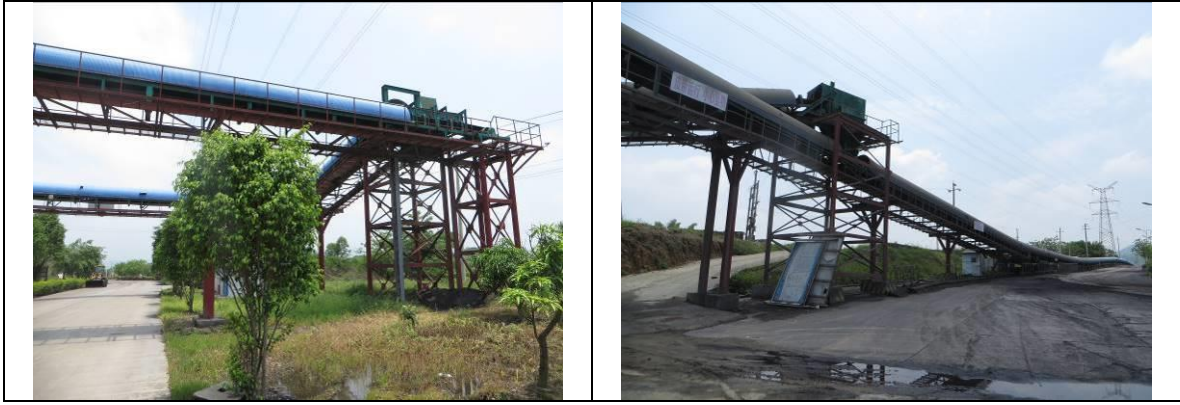
图2.5-1 百色煤炭物流项目运输廊道现状
