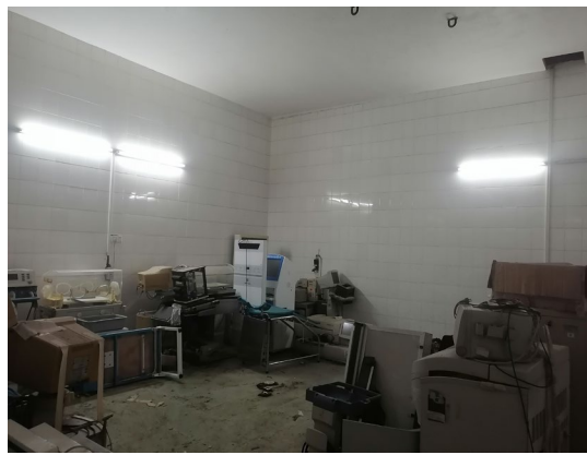
拟建机房内部现状
