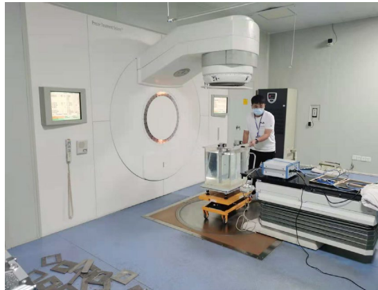
拟建机房西侧在用加速器机房现状
