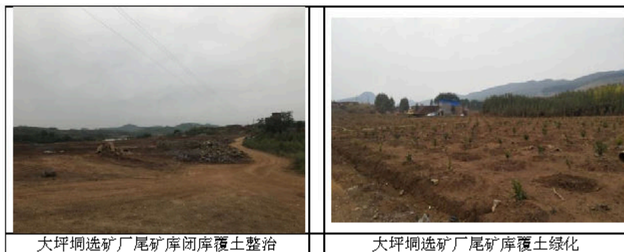
图 3.9-1 已进行覆土的武宣县大坪垌选矿厂尾矿库生态恢复治理
