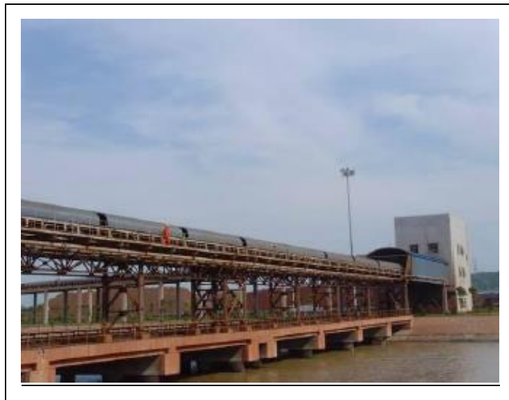
图 5.2-6 常见密闭皮带机示意图
