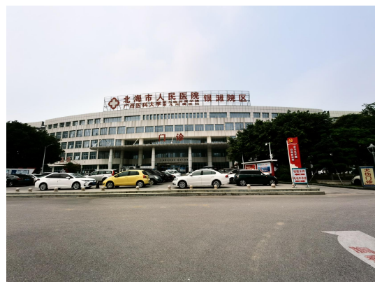
北侧环境现状（门诊医技综合楼）
