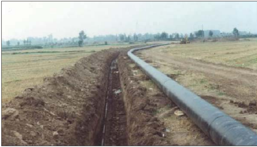
图 2.3.2-2 国内同类工程管道开挖实景图片
