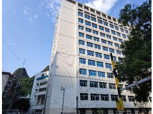
项目北侧医院 3 号楼
