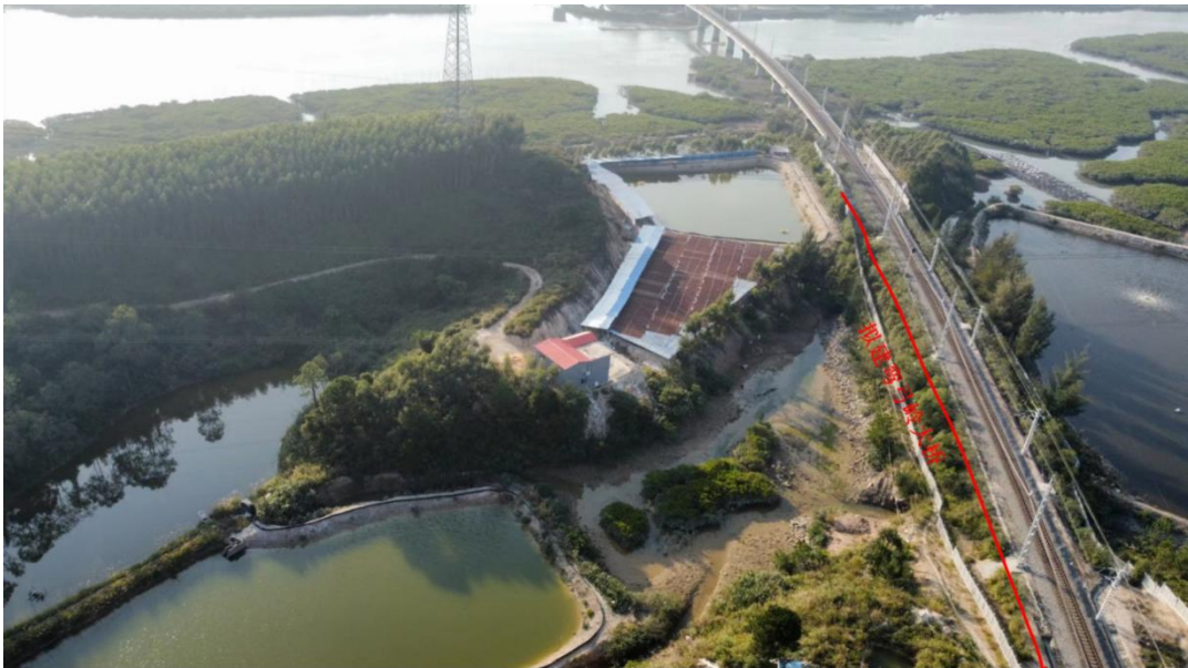
图 5.3-14 拟建望鸭江大桥和弯弓岭大桥周边海域养殖现状
