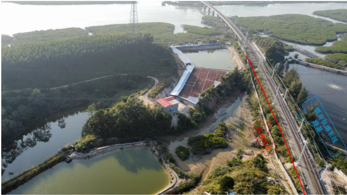
图 5.1-27 弯弓岭大桥桥址现状图
