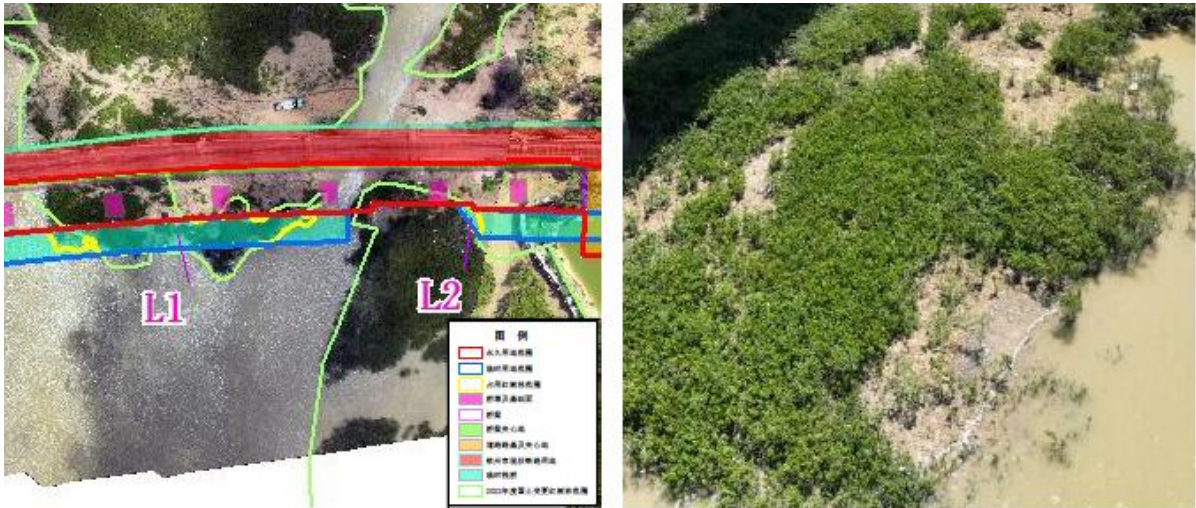
图 4.5-6 临时占用红树林 L1、L2 号斑块航拍图及现状照片
