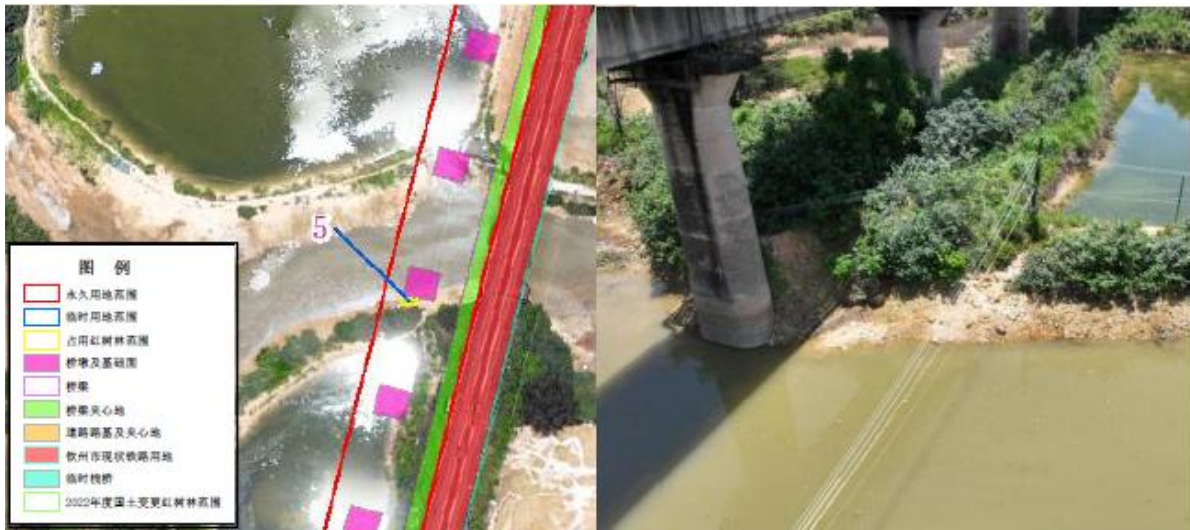
图 4.5-3 永久占用红树林 5-9 号斑块航拍图及现状照片
