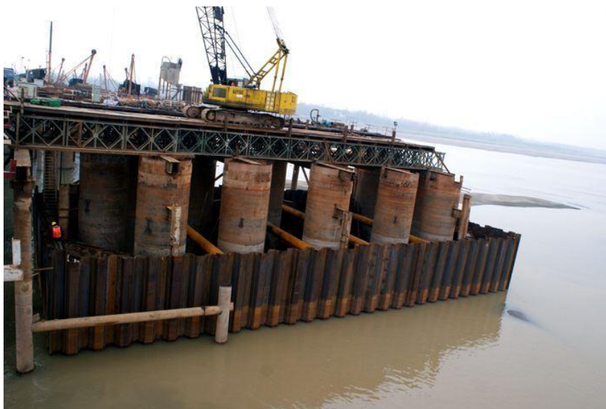
图 4.3-5 桥梁围堰施工示意图
