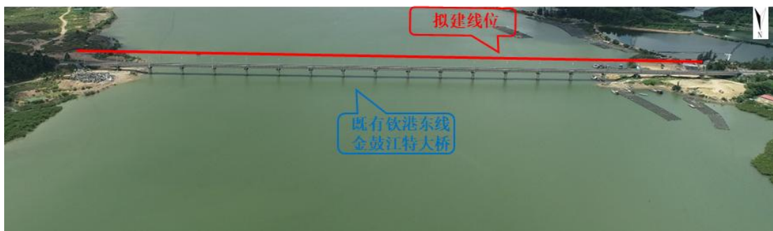
图 5.1-31 金鼓江特大桥桥址现状图
