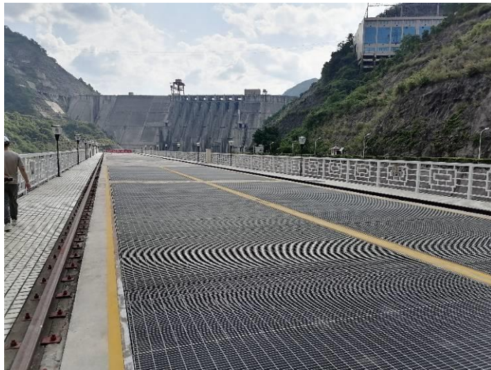
图 7.1.5-35 供水工程方案二水源点处现状
