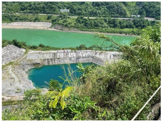
通航建筑物工程开挖基坑
