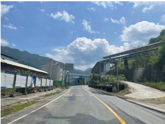
龙滩水电站坝址下游沿岸公路
