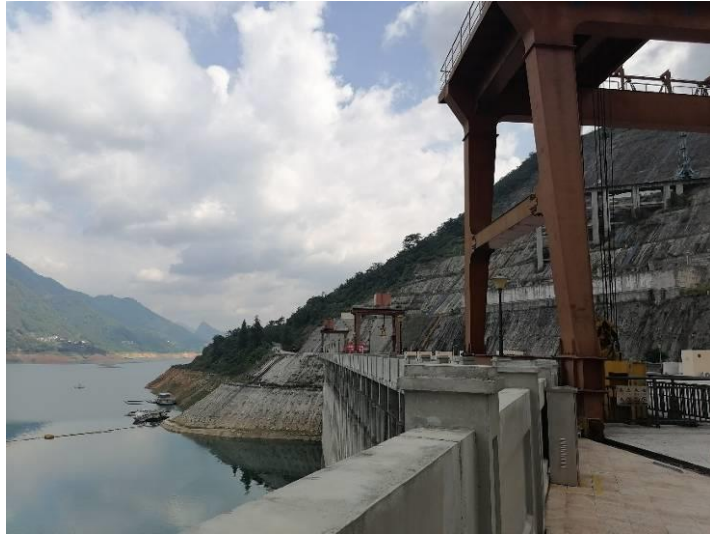
图 7.1.5-34 供水工程方案一水源点处现状
