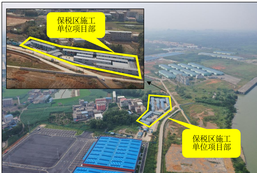
图2.2-2 保税区施工单位项目部现状图
