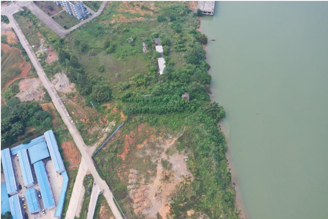
码头前沿现状
