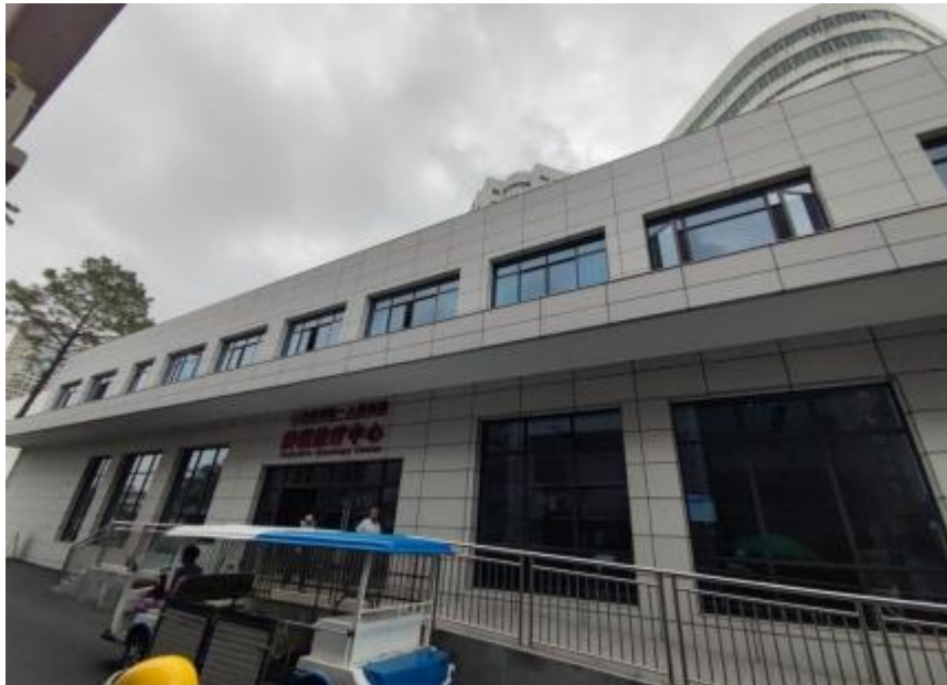
图 1-3 项目拟建场址东侧环境现状
