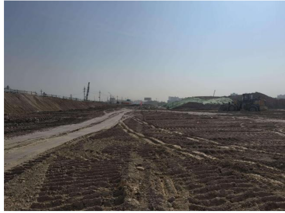
源库南侧现状
