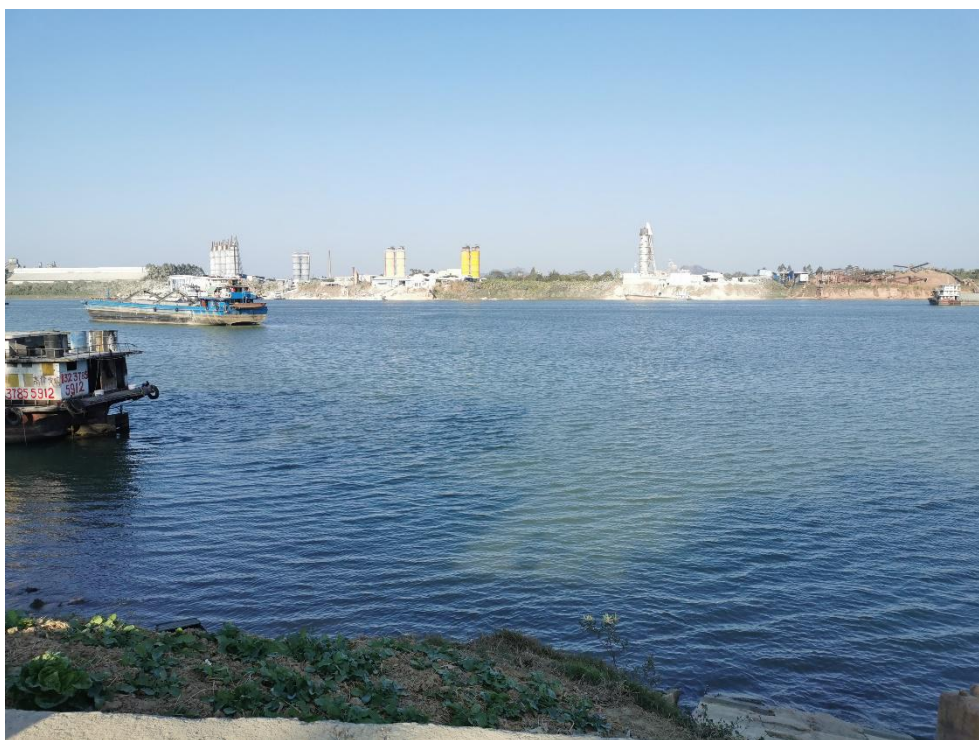
图 2.3-4 路线跨越浔江桥位现场图
