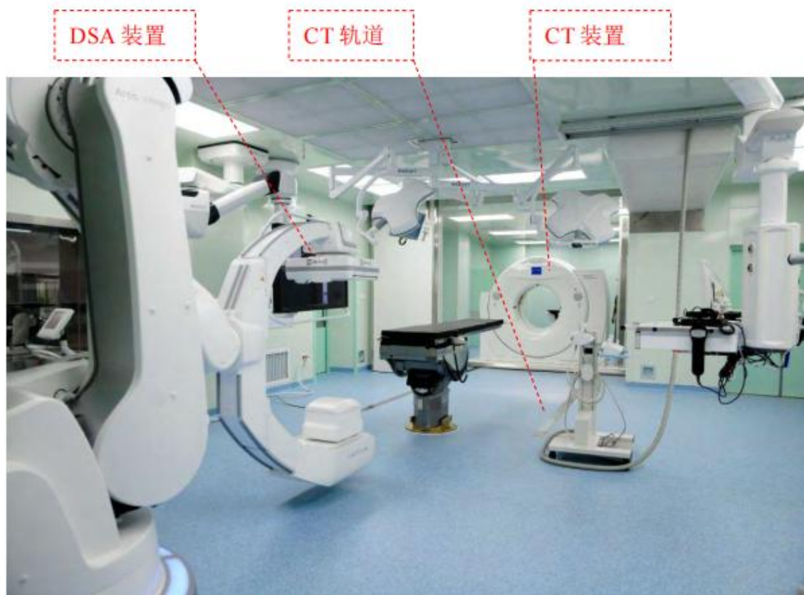
图 9.3-3 DSA+CT 复合手术室设备组成图
