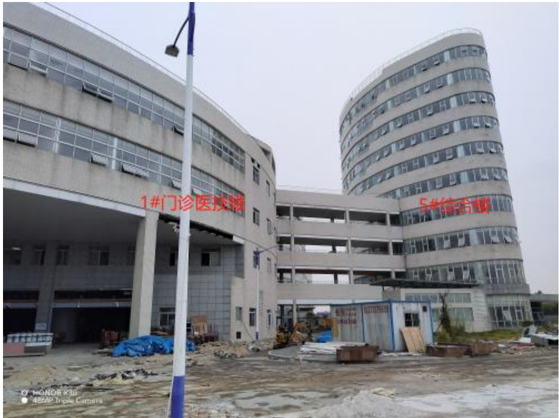
1#门诊医技楼北侧5#综合楼
