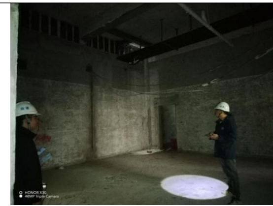
1#门诊医技楼一层放射科DSA机房
