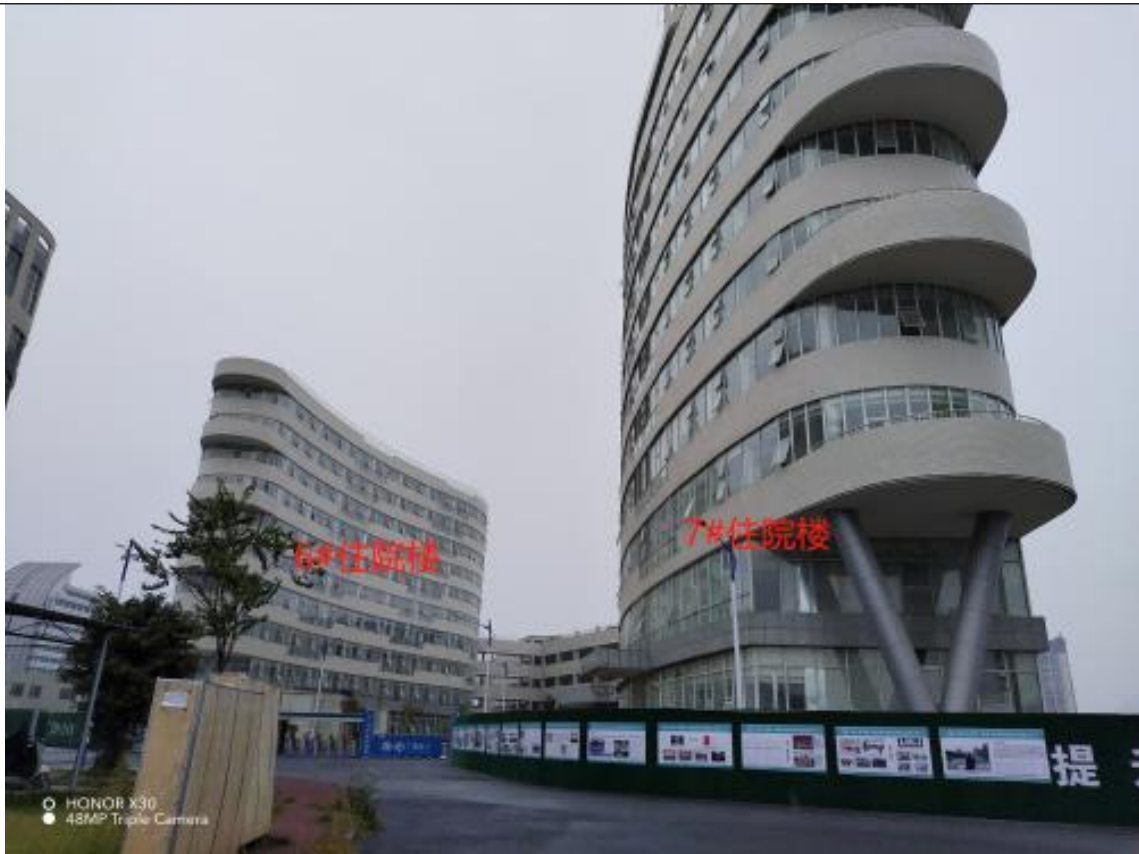
1#门诊医技楼北侧6#住院楼、西侧7#住院楼
