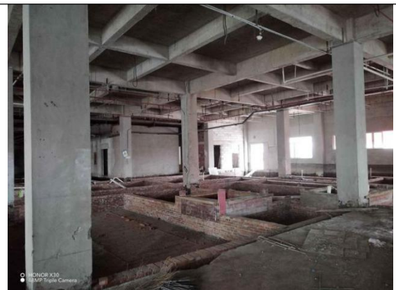
1#门诊医技楼一层核医学科场所（2）
