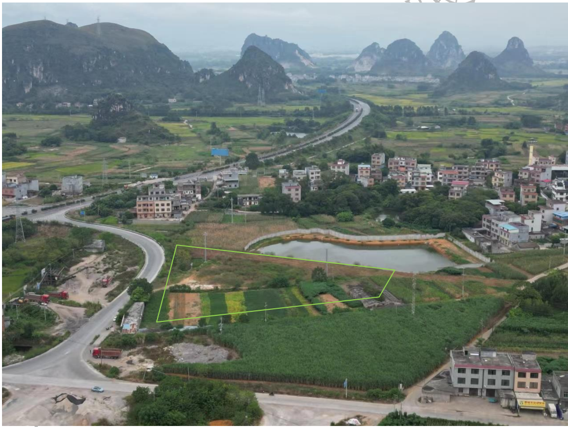
图2.2-1防洪堆货场现状
