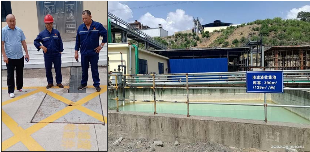
图 4.9-1 吉朗钢业渗滤液收集井和收集池
