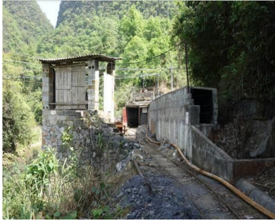
现有排水井（原 2#通风井）
