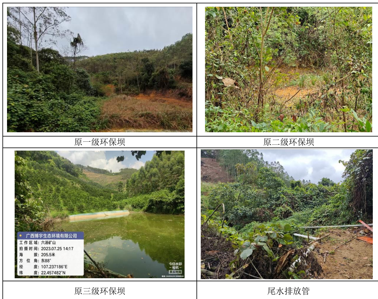
图2.1-12 环保坝及尾水排放管情况
