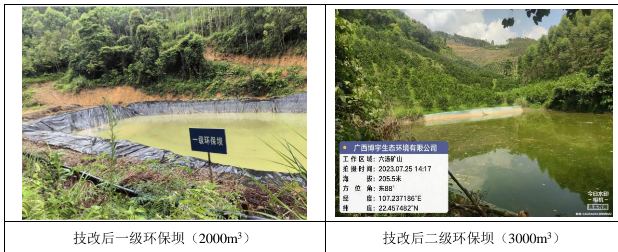
图2.1-13 技改后环保坝建设情况
