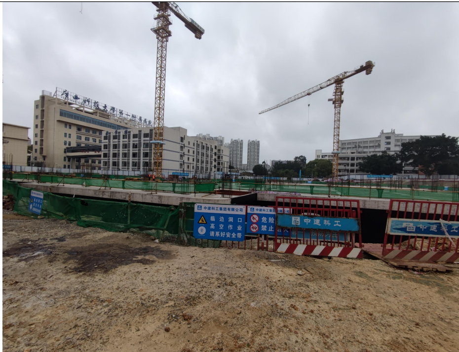
图 1-2 拟建核医学科所在的医技综合楼现状
