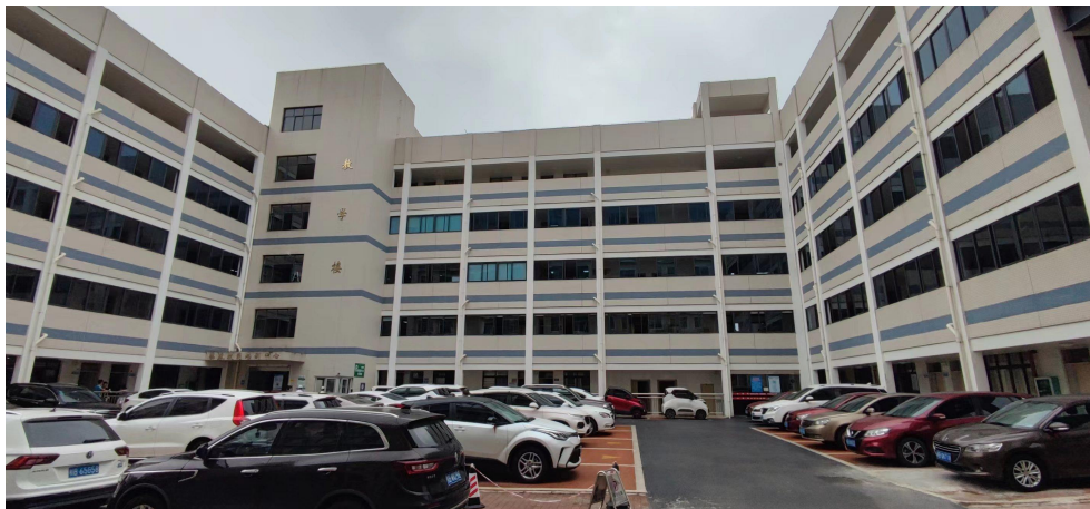
图 1-5 医技综合楼西侧教学综合楼环境现状
