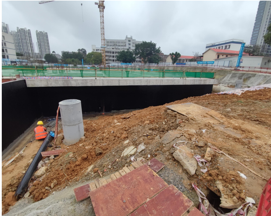
图 1-7 医技综合楼北侧环境现状
