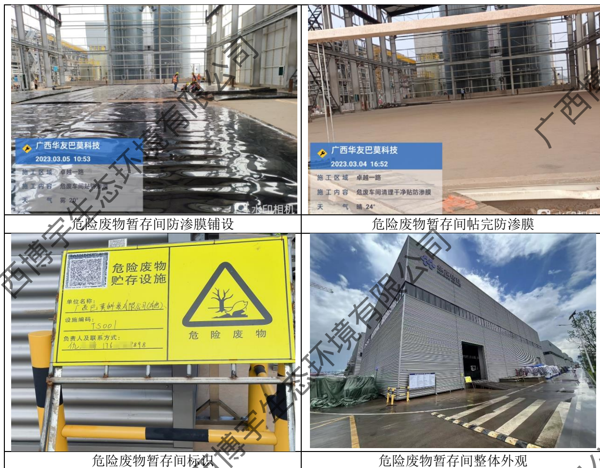
图6.2-4 巴莫项目危废暂存间建设情况
