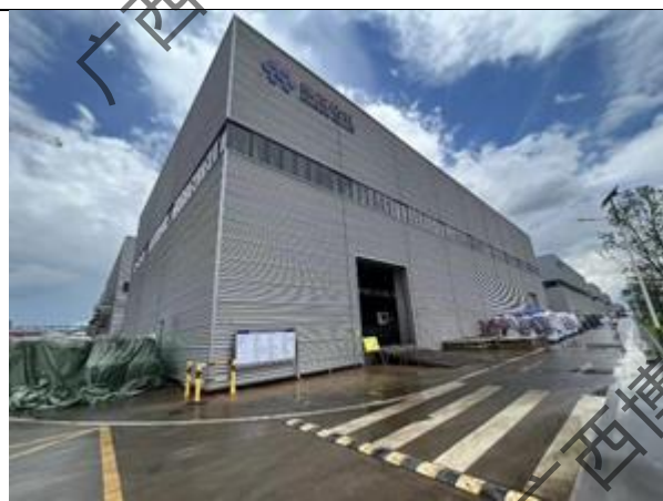
依托危废暂存间
