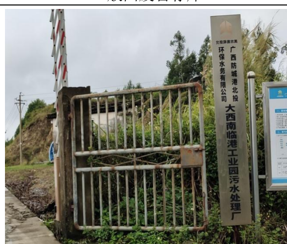
园区污水处理厂
