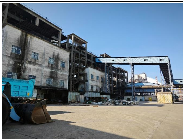
拟拆除煤气站
