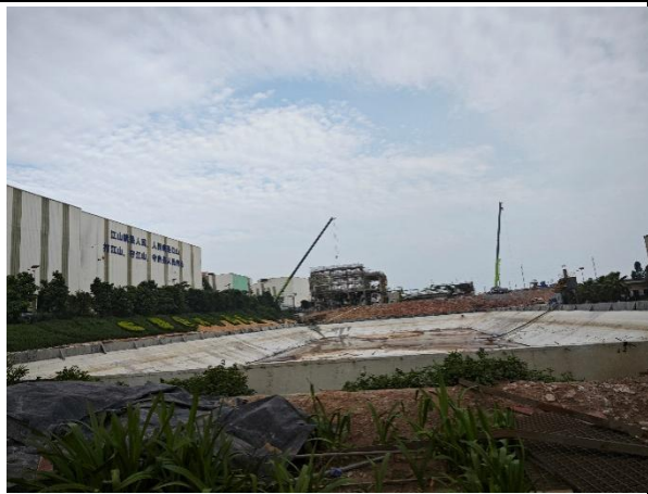
现有工程 4 万 m 3 事故池
