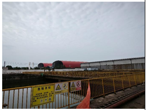
现有工程 5 万 m 3 初期雨水池
