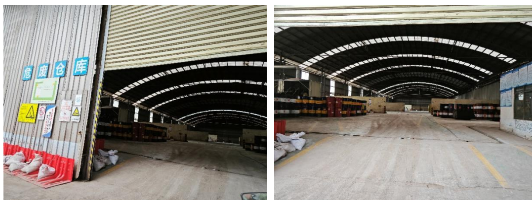
图2.1-6 北港新材料现有危废暂存间（综合危废仓库）现场照片
