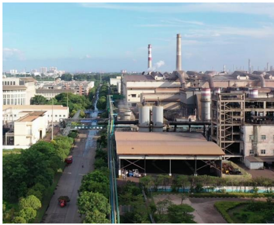
北港新材料现有厂区
