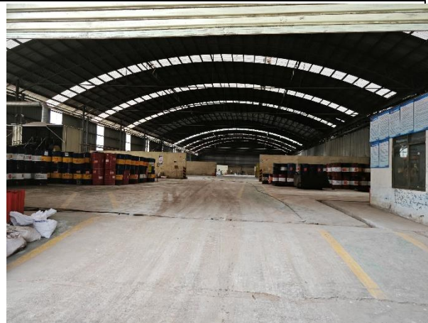
现有工程危废暂存库
