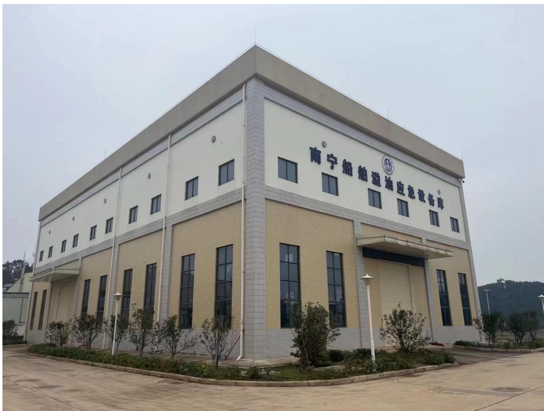
图 7.6-1 南宁船舶溢油应急设备库
