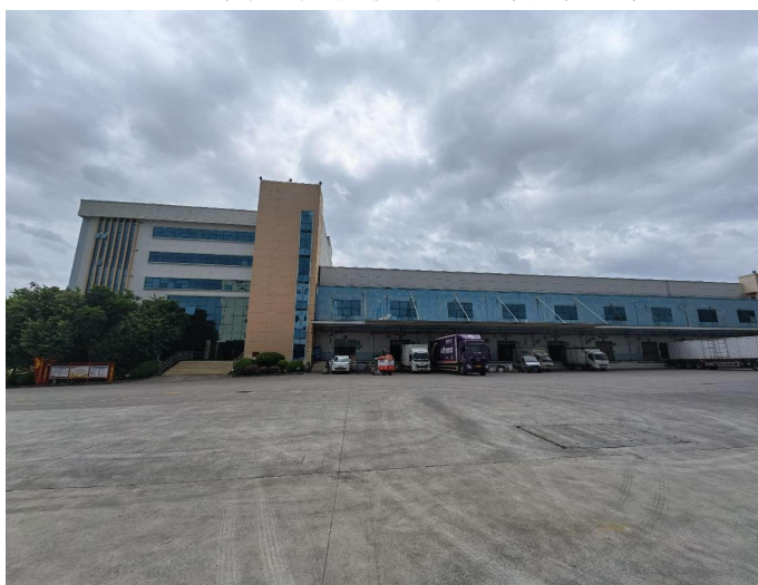
东侧环境现状（管理办公楼和物流中心）
