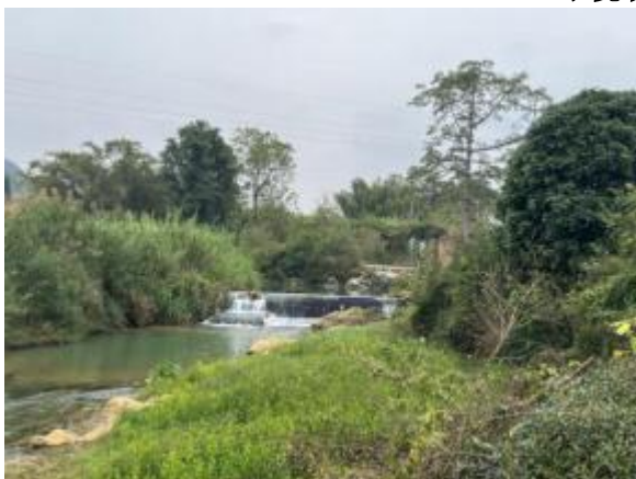
乔建镇慕垦水源地取水口
