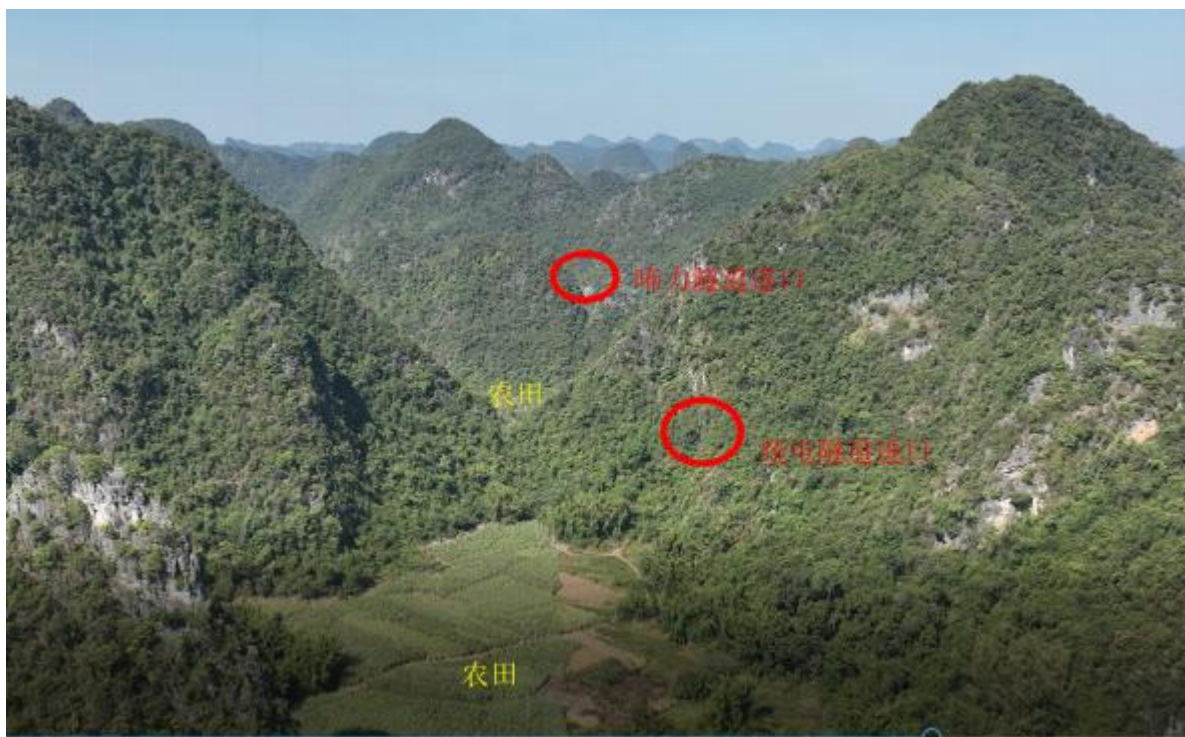
图 4.3-13 统屯隧道和喀屯隧道周边环境现状图
