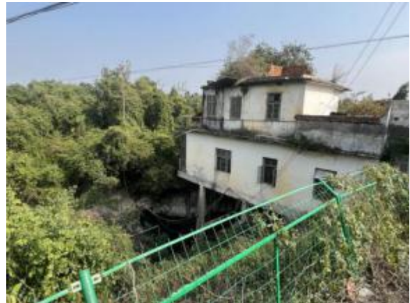
乔建镇博浪村小龙潭水源地取水口
