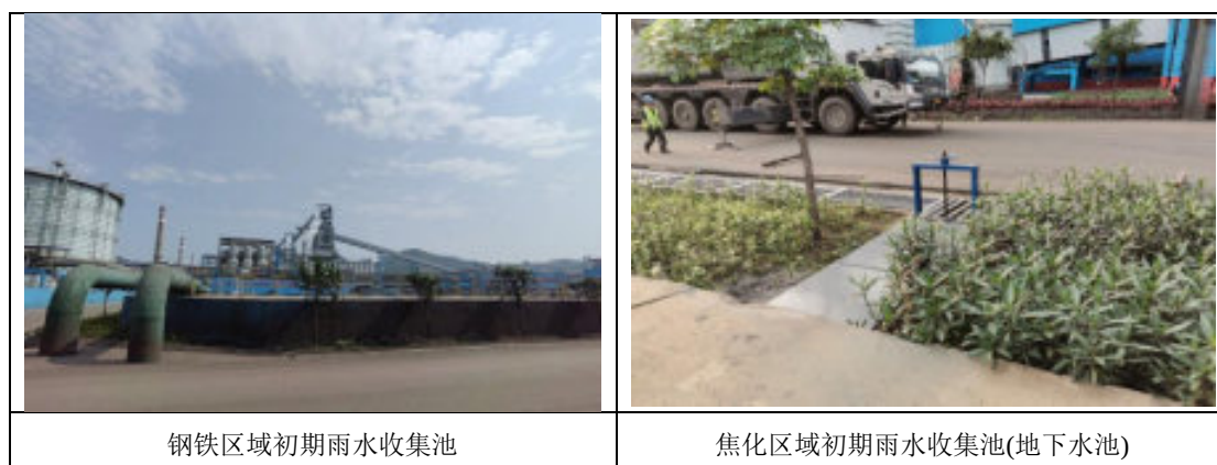
图 3.1-28 初期雨水收集池
