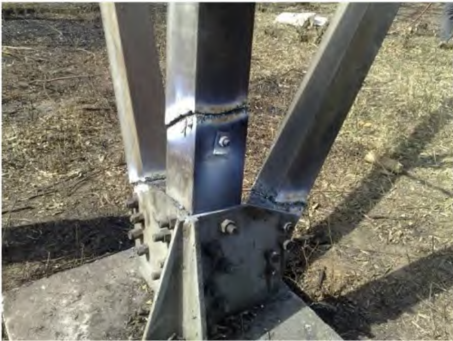
图 3-4 塔腿主材及八字铁切割工程实景图
