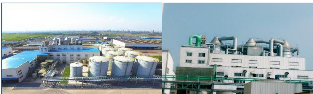
图6.2-4 MVR 设备实景图
