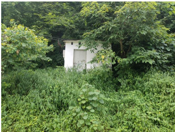
龙岸镇三灵村鸡灵屯饮用水水源地取水口
