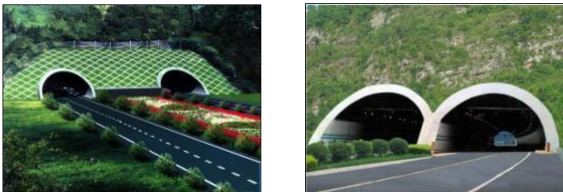
图 2.4-12 主线隧道洞口型式和景观设计效果图
