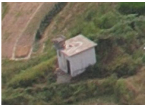
黎邓屯地下水取水口
