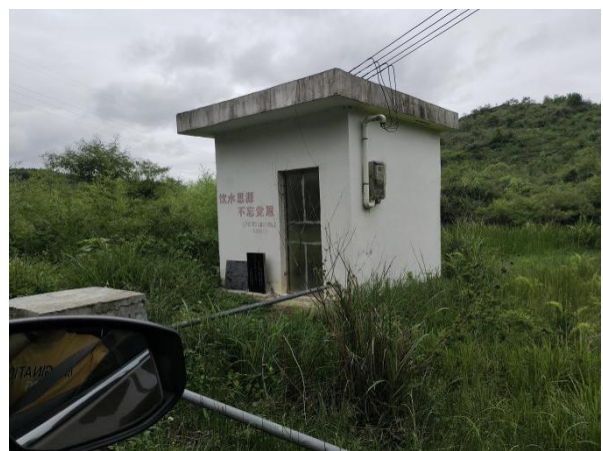
塘底屯分散式地下水取水口
