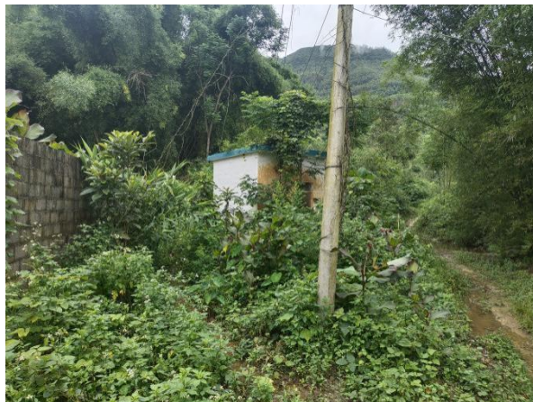
龙岸镇三灵村峡山屯饮用水水源地取水口
