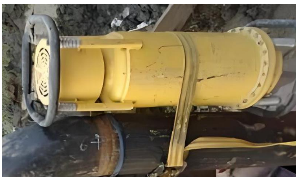
图 9-6 定向机的安装固定示例
